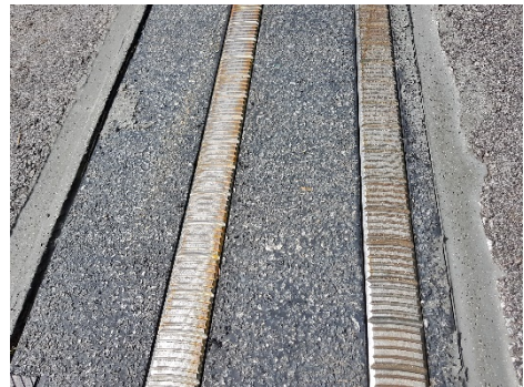
Figure 1 - APS Alimentation Par le Sol - Copyright ALSTOM
