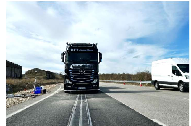
Mesure des déformations de la chaussée sous passage d'un poids lourd de 40 tonnes
